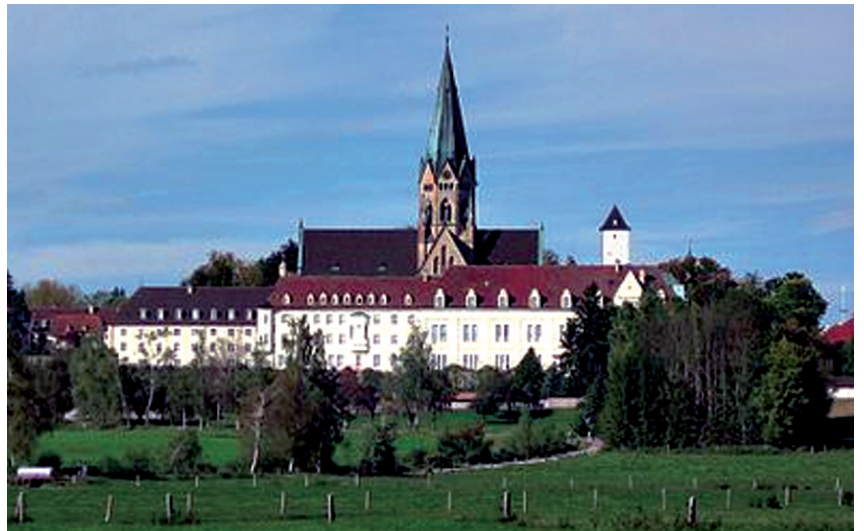
Gesamtansicht der Klosteranlage
